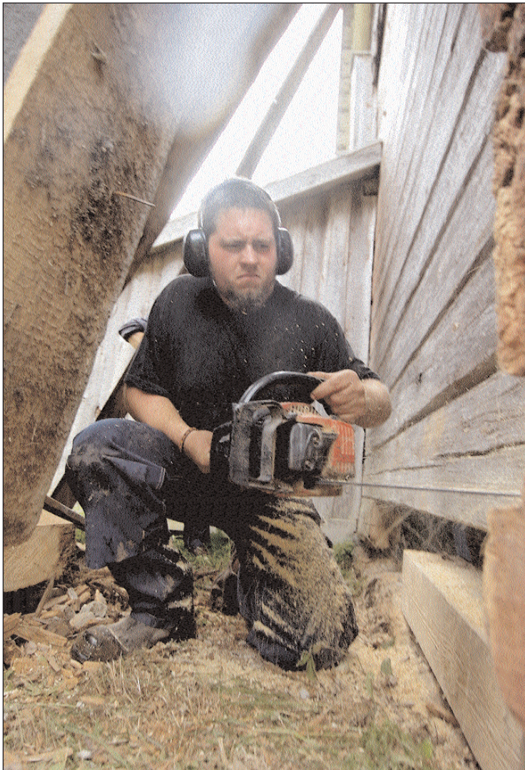
Motorsåg. Henrik Nyberg är hantverkare och håller på att ta bort en bit murken stock.
