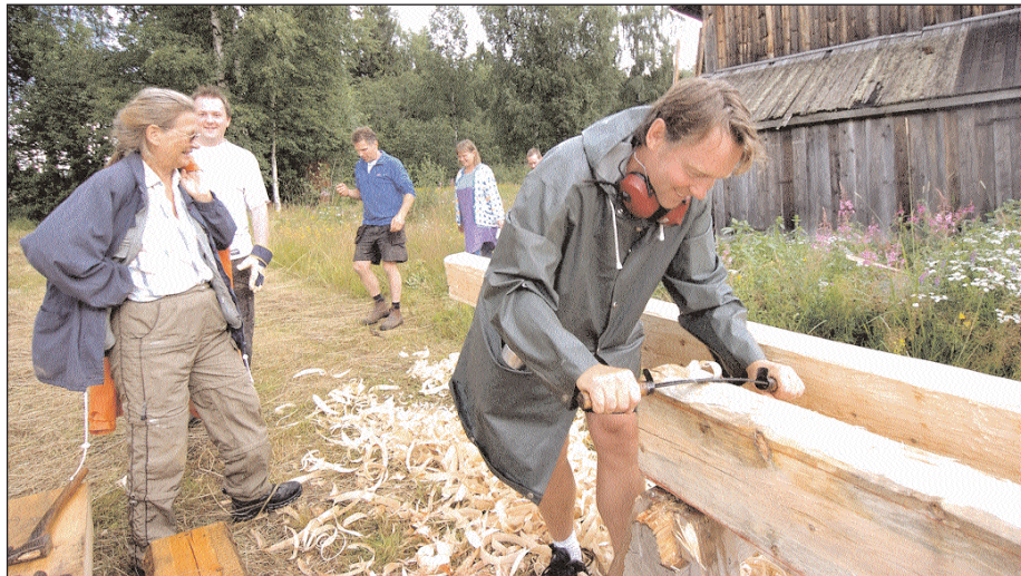
Fura. Thomas Wenner från Norrköping lär sig byggnadsvård under två semesterveckor. Han bandar stocken för att få en jämn böjning. I bakgrunden Solgruvstugan.
